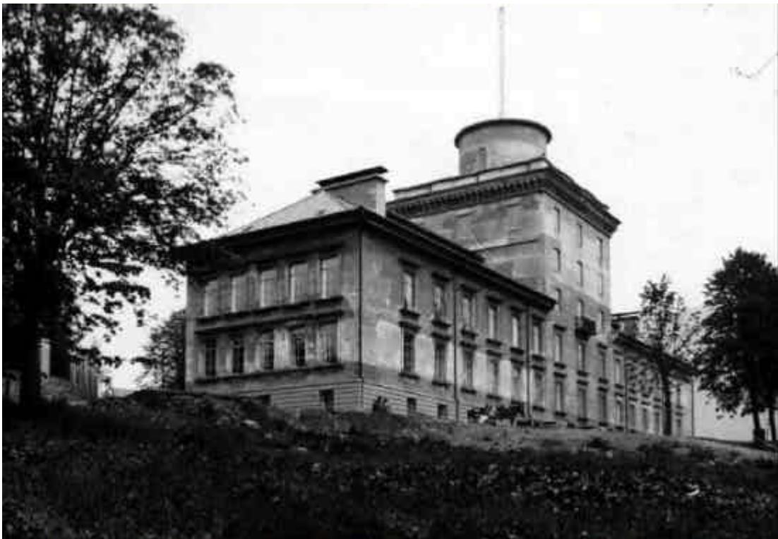
Détail du bâtiment de Géophysique, où l'on distingue l'antenne qu'ils utilisaient en 1928 pour les communications avec les cargos.
